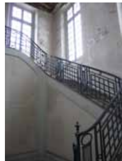
Fig. 8 – Hôtel du Grand Contrôle : le nouvel escalier (1783-84). Cliché Ph. Cachau.
