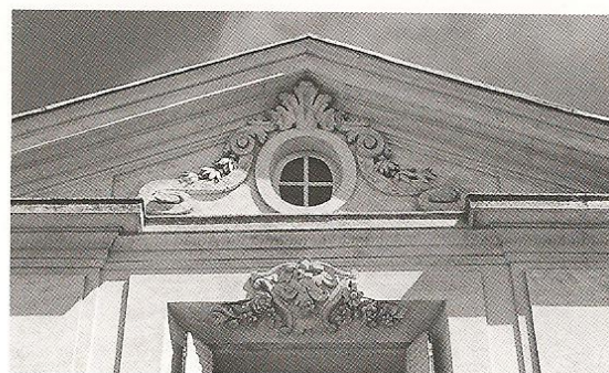
Fig. 22 - Haut de l'avant-corps central côté cour (détail).
