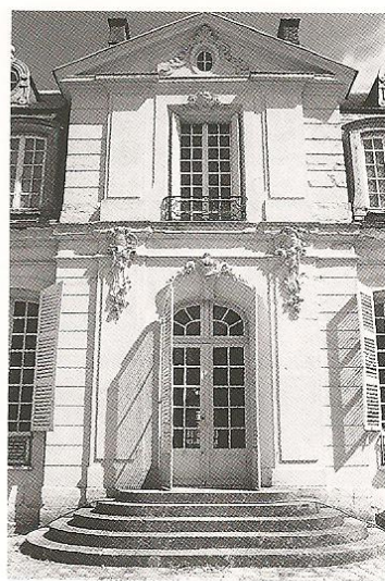
Fig. 21 - Avant-corps central sur la cour.
